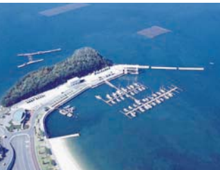
●内海フィッシャリーナ。最新設備を備えたクラブハウスがあり、136隻を収容できる
