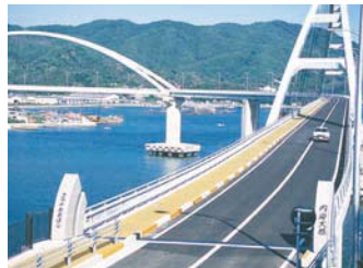
●平成元年に完成した内海大橋は、本州と島を結ぶ重要なアクセスルート。全長832m
